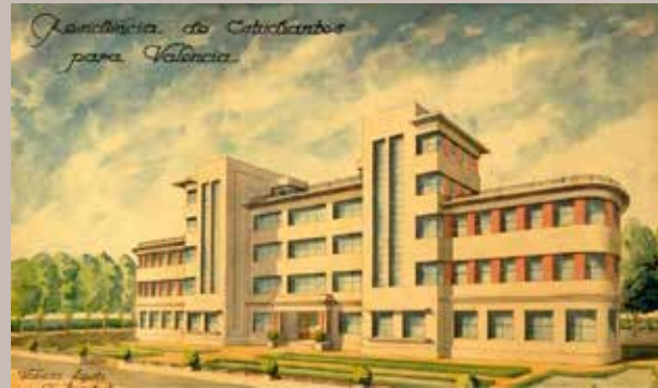
Residencia de Estudiantes para Valencia. Arquitecto Javier Goerlich, 1935-41. Avda Blasco Ibañez. Valencia. (Cortesía Fundación Goerlich).
